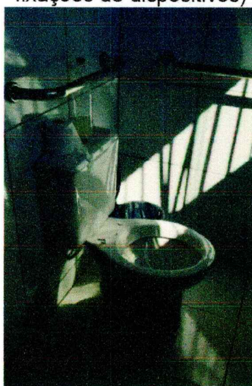
Tampa (Reparo hidráulico)
