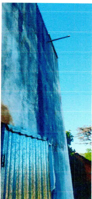
Infiltrações (impermeabilização)
