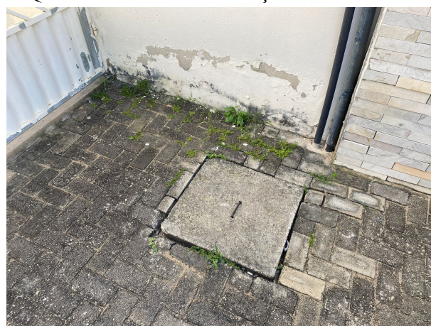
CAIXA DE INSPEÇÃO
