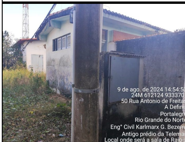
Foto 05: Poste da Telemar (permanecerá) e mureta com padrão de entrada de energia (à ser demolido).
