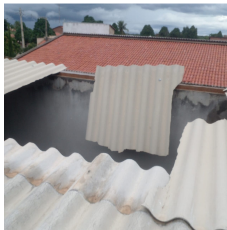
COBERTURA CENTRO ADMINISTRATIVO
