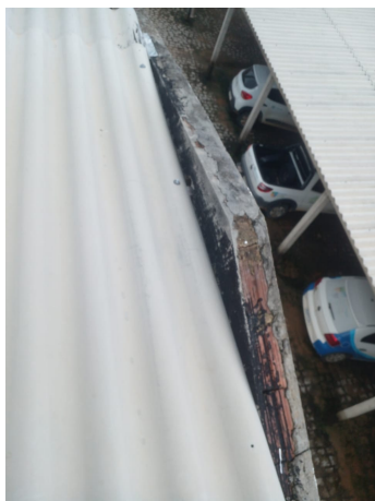
COBERTURA CENTRO ADMINISTRATIVO
